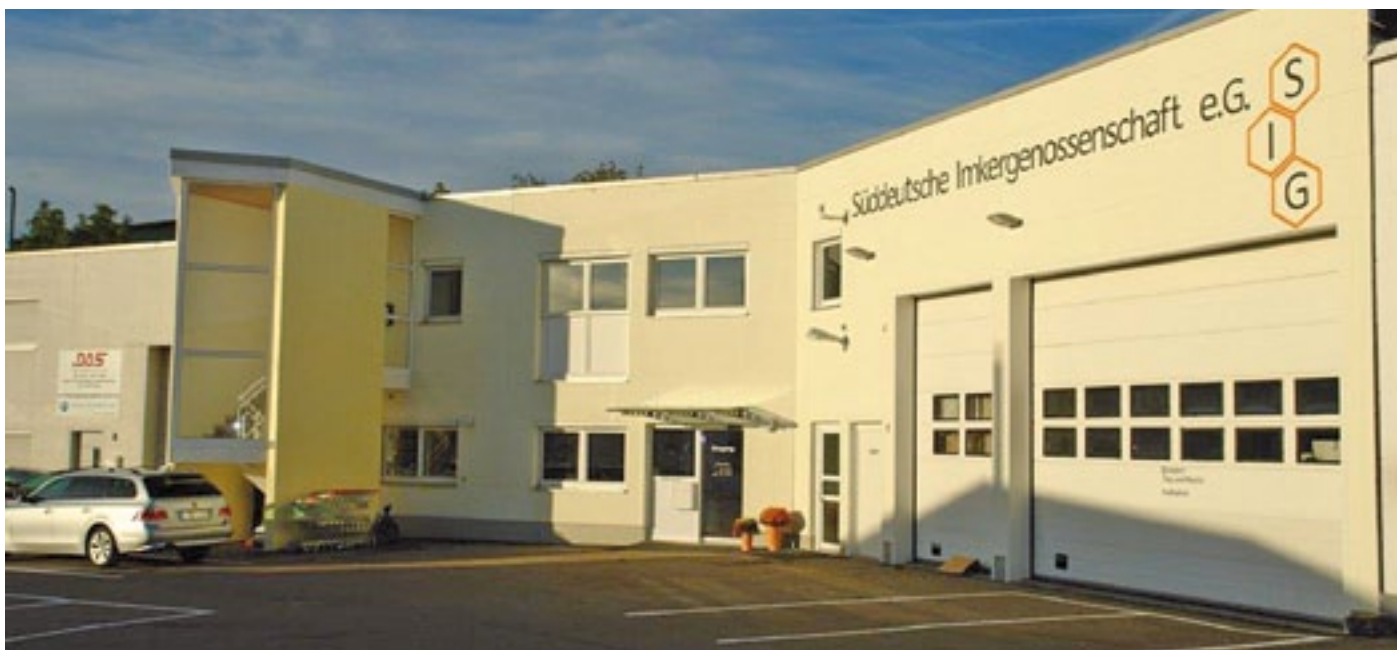
Außenansicht des neuen Betriebsgebäudes in Göppingen-Eschenbach
